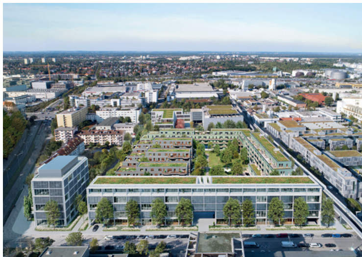
Hofmark zwischen der Preußenstraße und der Moosacher Straße
